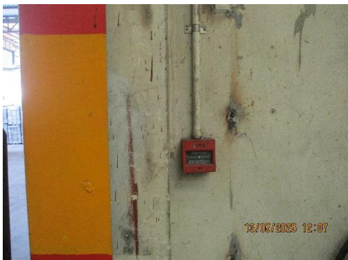
รูปที่ 36 สัญญาณเตือนภัย (Fire Alarm)
