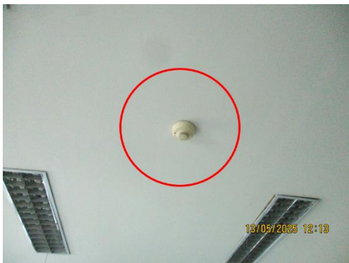
รูปที่ 35 อุปกรณ์ตรวจจับควันและความร้อน
